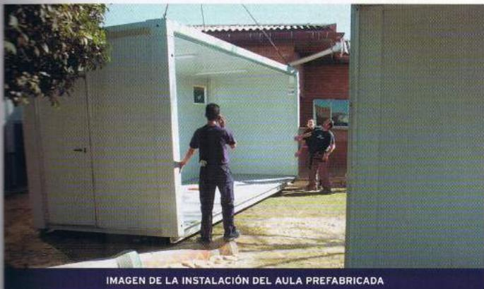
IMAGEN DE LA INSTALACIÓN DEL AULA PREFABRICADA
